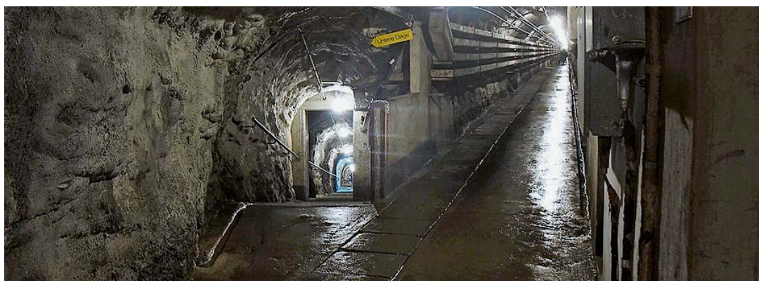
Die beiden Etagen sind durch ca. 20 Meter Fels voneinander getrennt.
